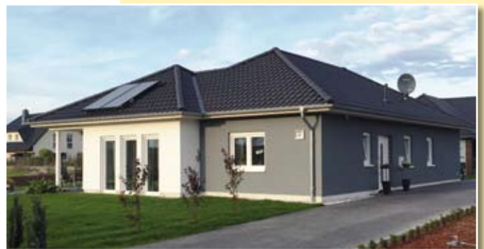
Ein Bungalow in Winsen (Aller) mit einem modernen Wärmedämm-Verbundsystem. Die Oberfläche der Fassade kann individuell nach den Wünschen der Bauherren gestaltet werden. Dies ist eine Alternative zu einer Fassadenoberfläche mit Verblend-Mauerwerk.
